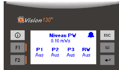
Anzeige bei 3 Pumpen und Rührwerk
